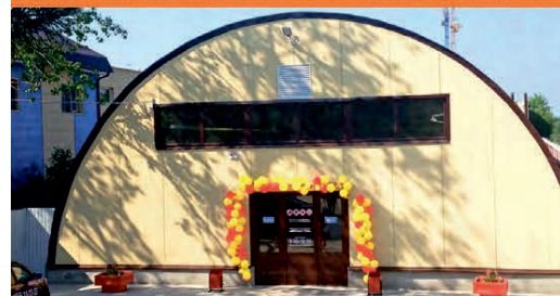
СКЛАДСКИЕ И ПРОИЗВОДСТВЕННЫЕ ПОМЕЩЕНИЯ
