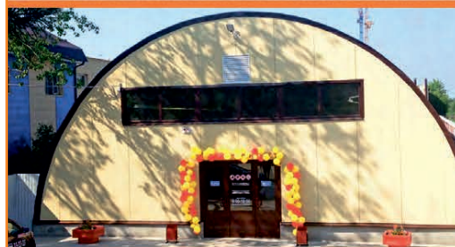
СКЛАДСКИЕ И ПРОИЗВОДСТВЕННЫЕ ПОМЕЩЕНИЯ
