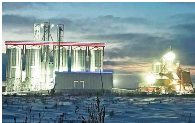
Строительство элеватора ООО «Компания Русское зерно»
